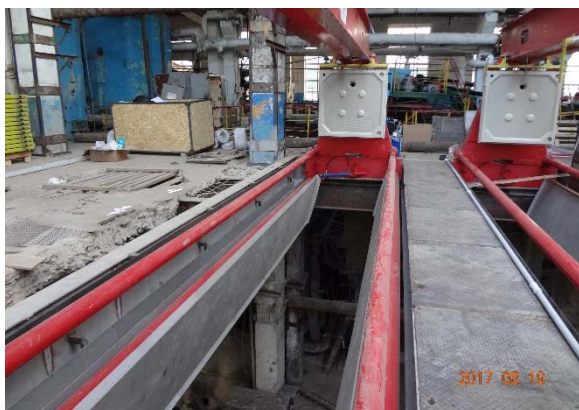
Рис. 1. Начало монтажа фильтр-прессов
