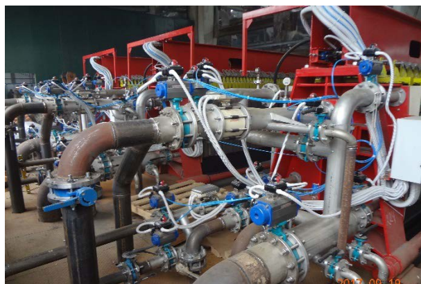
Рис 2. Фильтр-прессы готовы к работе
